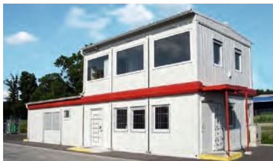
Дополнительное помещение на предприятии
