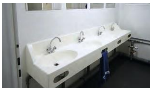
Лоток с двумя или четырьмя умывальными раковинами
