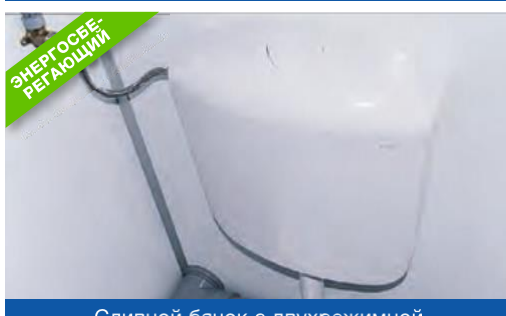
Сливной бачок с двухрежимной системой смыва
