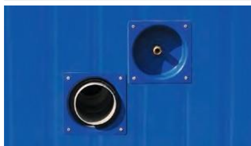
Вход для подключения водопровода утоплен в стене
