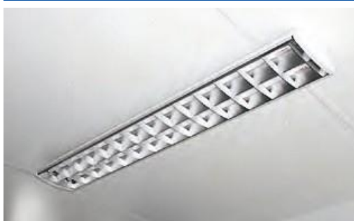
Светильники с зеркальным отражателем
