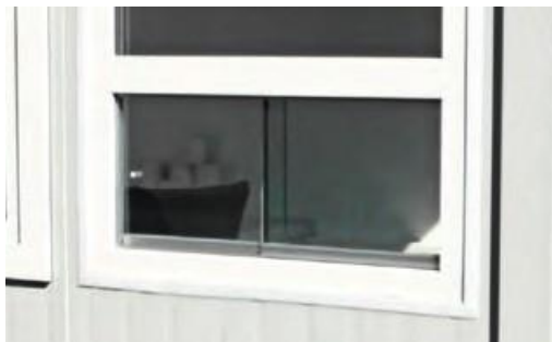
Окно с параллельно-сдвижной створкой
