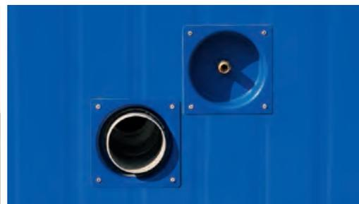
Вход для подключения водопровода утоплен в стене
