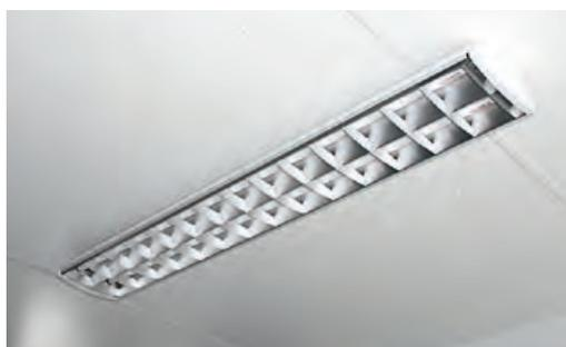
Светильники с зеркальным отражателем
