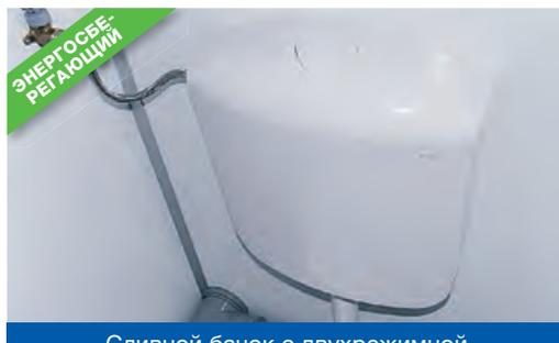
Сливной бачок с двухрежимной системой смыва
